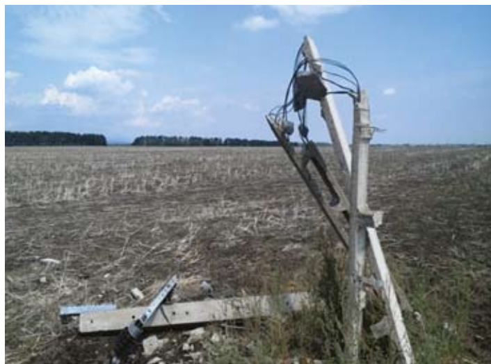
1. ábra Extrém szélterhelés hatása egy közepfeszültségű hálózatra
