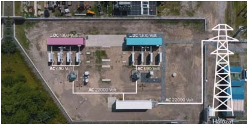
4. ábra ELMŰ-ÉMÁSZ akkumulátoros villamosenergia-tároló
