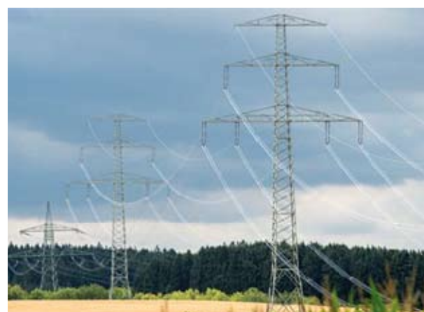
2. ábra Azonos keresztmetszetű vezetékcsere (ACSS) sodronyra
