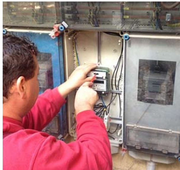
1. ábra Mérő felszerelése mérőszekrénybe
