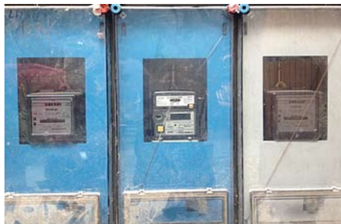
5. ábra Középen az okos mérő mérőszekrénybe szerelve
