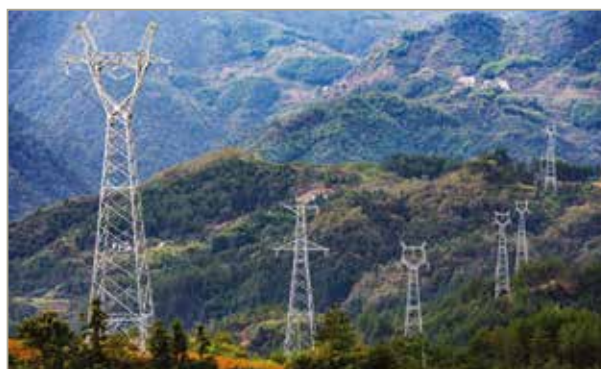
2. ábra Szabadvezeték-hálózat hegyes-dombos terepen (ferde felfüggesztési közők) [6]
