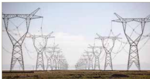
1. ábra Szabadvezeték-hálózat sík terepen (vízszintes felfüggesztési közők) [5]
