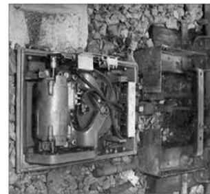
NDK Licenc alapján gyártott WSSB típusúvasúti váltóállítómű
