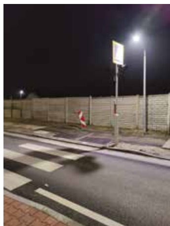
15. ábra Rossz helyre elhelyezett kiemelő világítás táblaárnyéka a zebrán
