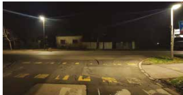
17. ábra Alacsony fénypontmagasságú kiemelő világítás egyenletlensége és kápráztató hatása
