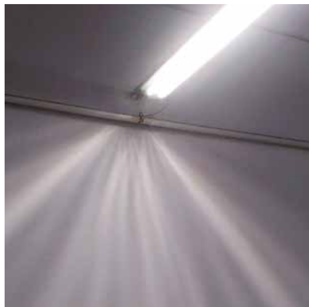
6. ábra Fényforráscsere utáni, nem megfelelő sugárzási kép
